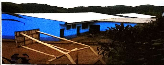
Foto 1: Vista panorámica de cambio de techado de ambos módulos
