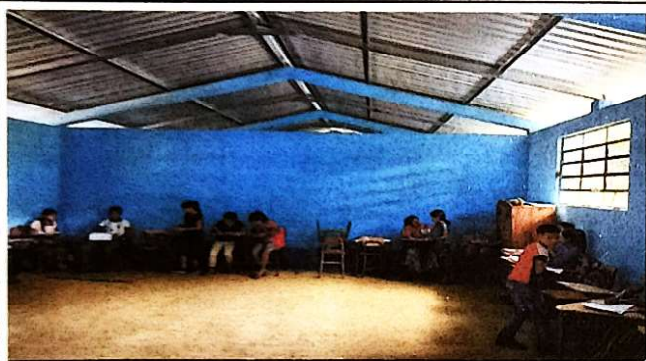
Foto 3: Vista del entechado nuevo más división de pared módulo dos
